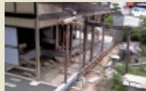
荒れ果てた空家を、アーティストと地元の方がいっしょになって修理していく。この、作品を展示するスペースづくりそのものも、アートプロジェクトの一環。
