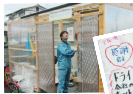
ボランティアセンター入口の 風除室の設置
