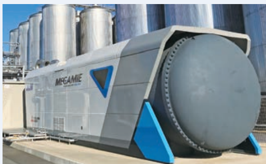
ビール工場排水由来のバイオメタンガスを活用した燃料電池発電システム
