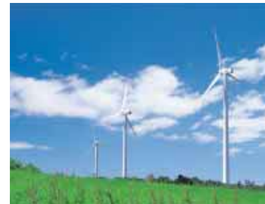
神奈川工場が発電を委託している秋田県南十和田の風力発電施設
